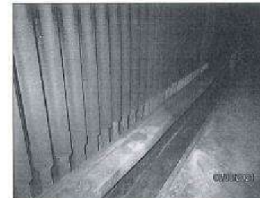
ภาพถ่ายของ Flue Tube ของเครื่องแลกเปลี่ยนความร้อน Economizer
