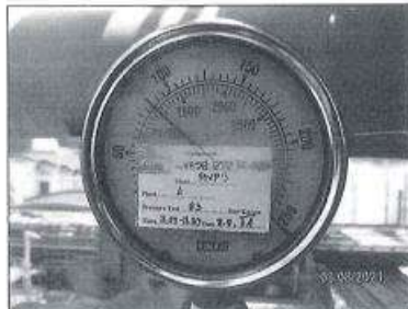
ภาพถ่ายของเกจวัดความดันไอน้ำของหม้อต้มไอน้ำ Steam Drum ในเครื่องจักรกลโรงงาน
