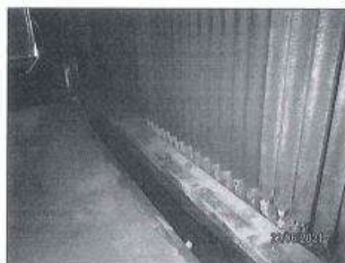
ภาพถ่ายภายใน Economizer ของหม้อไอน้ำ แสดง Flooded Tube ที่อุดตัน
